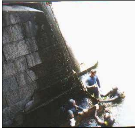
Foto 4: Colocación del dique metálico
